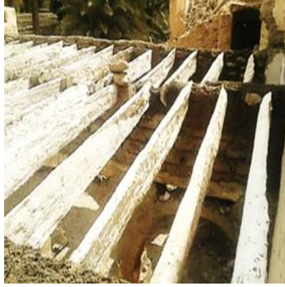
شكل رقم (15): تثبيت سنورات السقف
