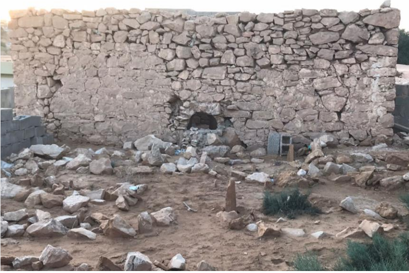
الصورة (4)الواجهة الجنوبية للمسجد العتيق جهة الجنوب.
