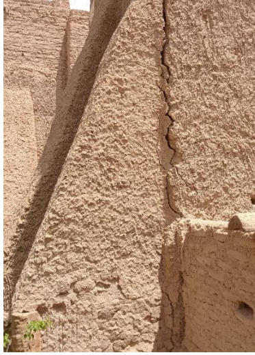
شكل رقم (18): بوليصة حديثة البناء منفصلة عن الحائط
