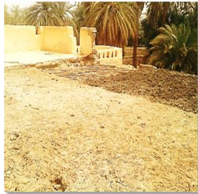
شكل رقم (18): صب مونة السقف
