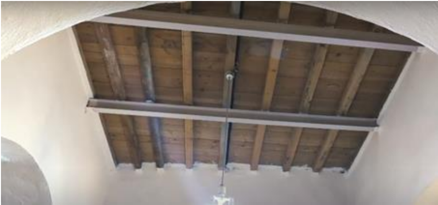
شكل رقم (5) : استخدام الخشب في سقف المسجد ضمن أعمال التوسعة
