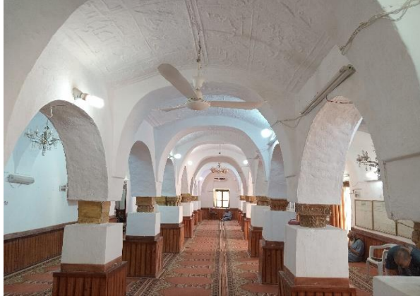
شكل رقم (14): سقف من الدمس في جامع يونس
