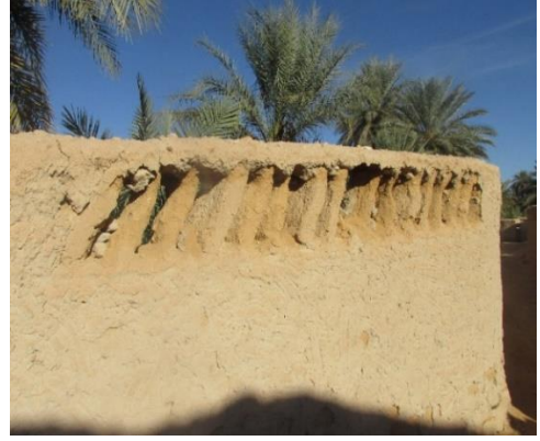
شكل رقم (15): حائط متآكل من الأعلى
