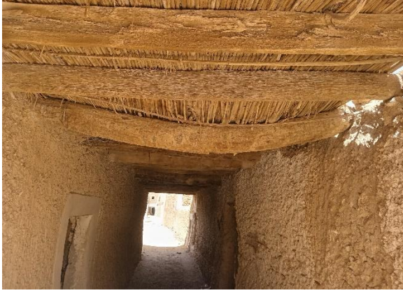
شكل رقم (26): إنحناء الصنور بسبب عدم الجفاف التام
