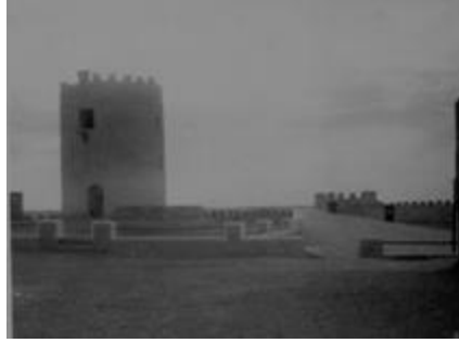
شكل(15- ج): صورة تظهر استغلال الصومعة الجنوبية كبرج مراقبة إبان الاحتلال الإيطالي وموقعاً للرصد الجوي حيث تأسست أول محطة للرصد الجوي في هذا الموقع الصورة (عن: toranealibicababia.altervista.org )
