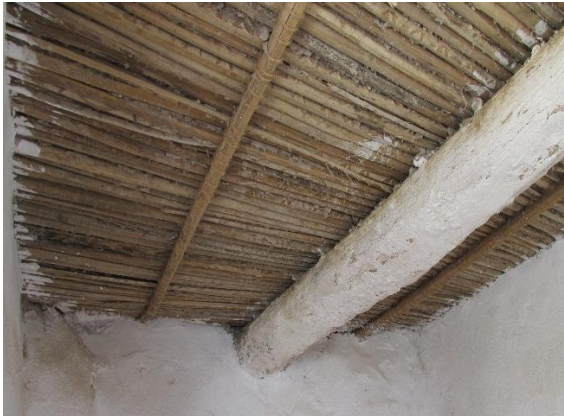
شكل رقم (28): مسافة كبيرة بين الصنورة وحافة السقف
