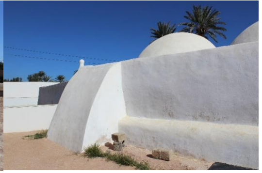
الشكل رقم (11) يوضح الجدران حول بيت الصلاة مدعومة بمصاطب
