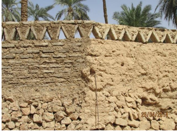
شكل رقم (20): ربط حائطين قديم وحديثة بطريقة خاطئة
