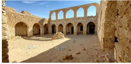
شكل(12): صورة للصحن الرئيسي لقصر الشني يتضح من خلالها العقود الخمسة المكونة من طابقين الشاخص 1 متر نحو الجنوب؛ (عمل ميداني- تصوير الباحث)
