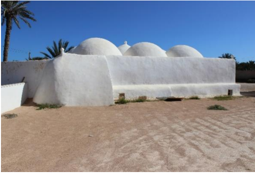
الشكل رقم (11) يوضح الجدران حول بيت الصلاة مدعومة بمصاطب
