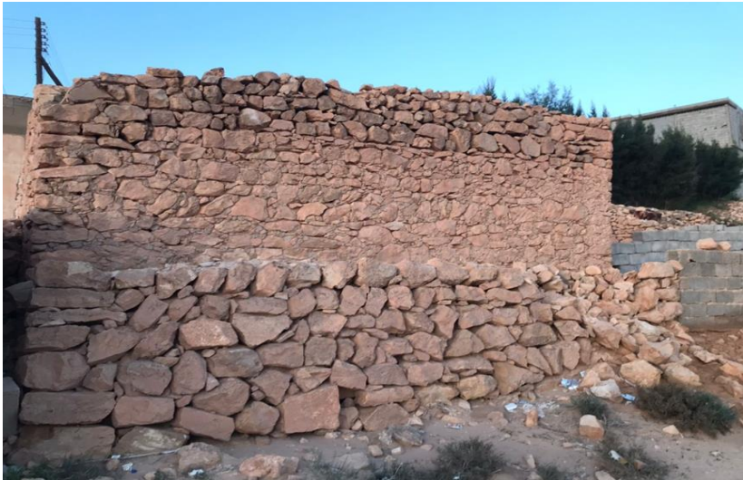
الصورة (3) الواجهة الجانبية للمسجد العتيق جهة الغرب
