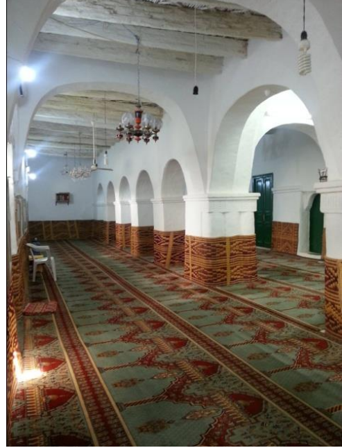
شكل رقم (22) يوضح استخدام جنوع النخيل في السقف،[6]
