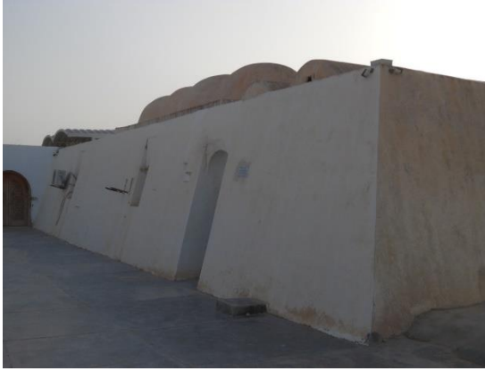
شكل رقم (14): مبنى زاوية الفواتير السبعة (القديمة) بزليتن - ليبيا. المصدر: الباحثون، 2024.
