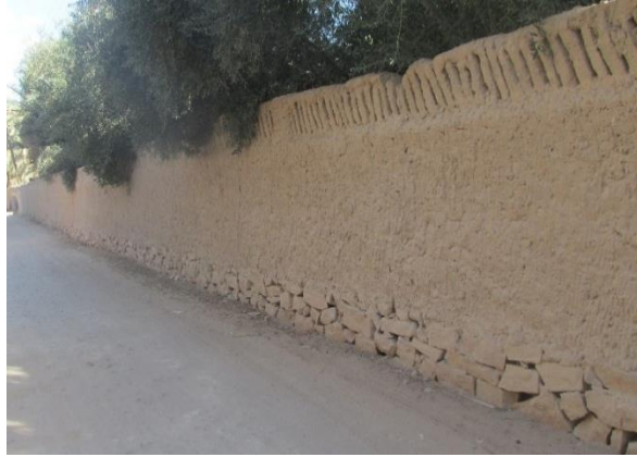
شكل رقم (12): أساس شريطي مرتفع عن سطح الأرض
