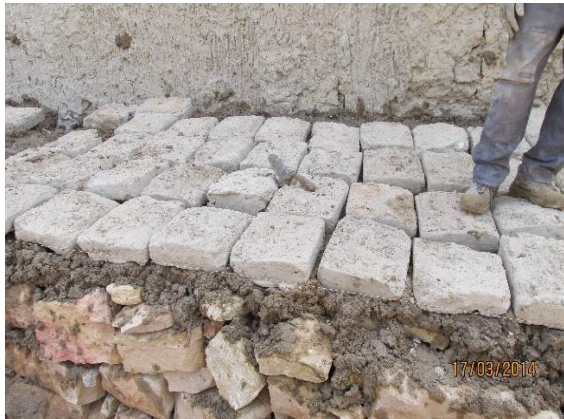
شكل رقم (17): بويلة مبنية بطوبات متلاصقة
