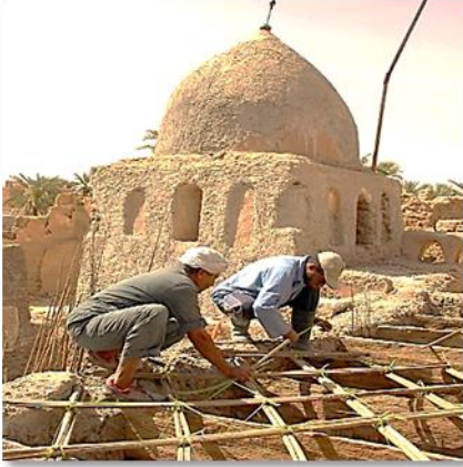
شكل رقم (17): تثبيت جريد السقف
