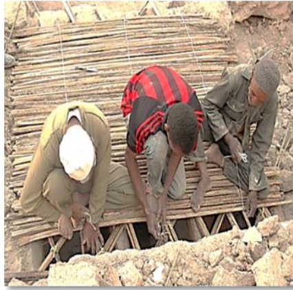
شكل رقم (16): عمل مربعات السقف
