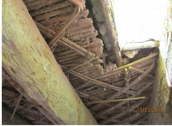
شكل رقم (29): سقف حديث يه فجوات
