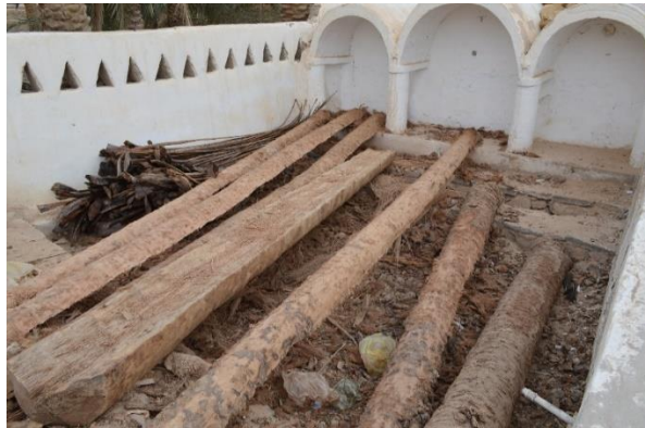
شكل رقم (11): صنورات في وضعية التجفيف
