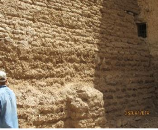
شكل رقم (16): حائط حديث ومتآكل بالكامل
