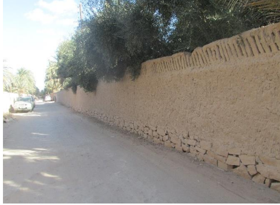
شكل رقم (6): اساس نموذجي مرتفع عن سطح الارض
