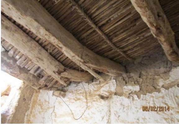
شكل رقم (22): صنورات سقف مكسورة
