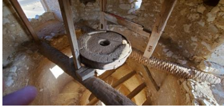
شكل(15- ب): صورة توضح شكل حجر طحن الصومعة الجنوبية الشاخص 1 متر؛ (عمل ميداني- تصوير الباحث)
