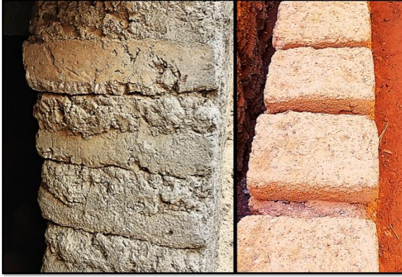
شكل رقم (9) بعض الصور توضح كيفية استخدام الطوب اللبن بالعرض
