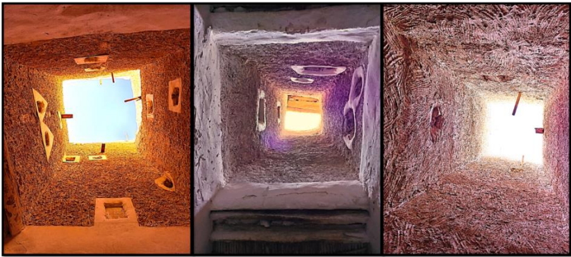
شكل رقم (32) صور لبعض نماذج الملاقف المنتشرة في أزقة شوارع مدينة غدامس القديمة.
