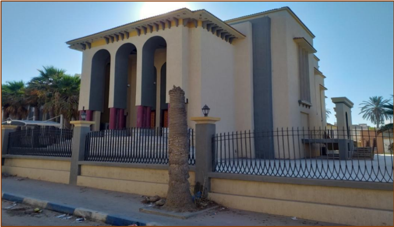
شكل (3_3) الواجهة الرئيسية لمبنى البلدية. تصوير الباحث
