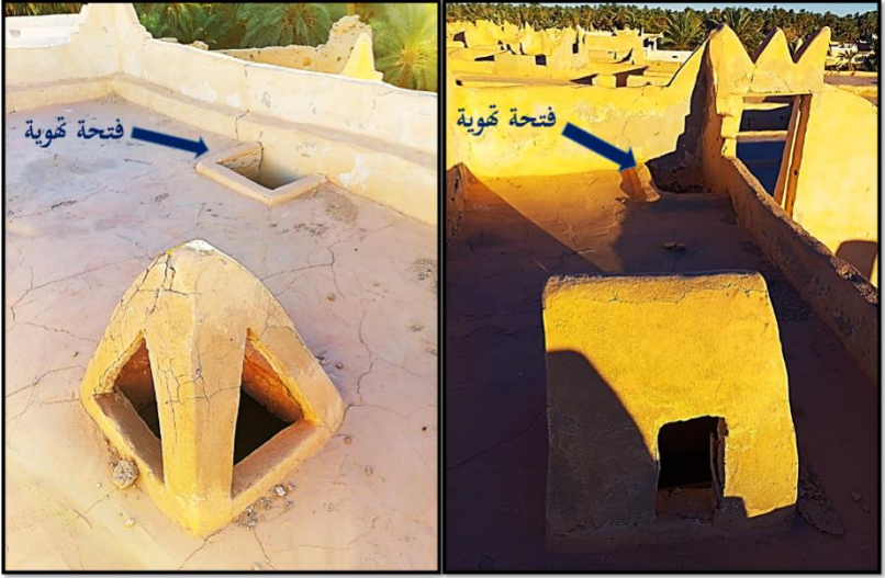
شكل رقم (27) صورتان منفردتان توضح كل واحدة منهما تواجد فتحة قومية ومدخنة في مطبخ واحد.
