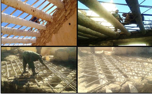
شكل رقم (22) بعض الصور الأخرى توضح كيفية ومراحل تشكيل شبكة
