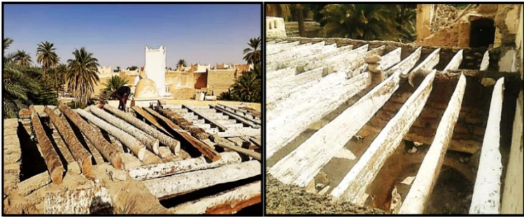
شكل رقم (18) صورة لتثبيت الصنور في أماكنها فوق الجدران وبداية أعمال السقف.
