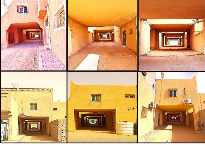
شكل رقم (42) صور أزقة بعض أحياء المدينة الحديثة التي تم تصميمها بشكل مشابه لأزقة المدينة القديمة.
