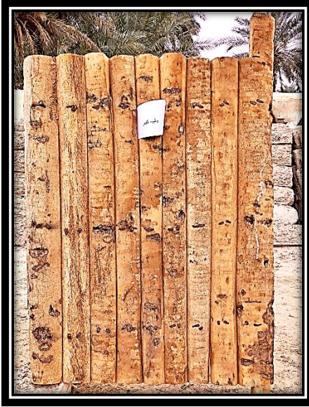
شكل رقم (29) صورة لباب منزل مصنوع من جذوع النخيل.
