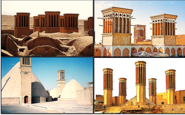
شكل رقم (3) صور توضح نماذج الملاقف الهوائية المتعددة الاتجاه.
