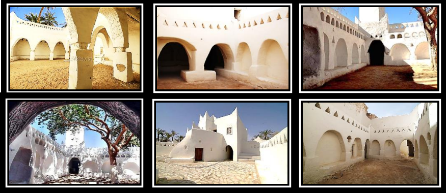
شكل رقم (14) صور لبعض الميادين والساحات التي تؤدي دور خزانات الهواء داخل المدينة القديمة.
