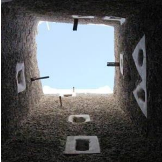
شكل (6) فتحات الإضاءة والتهوية لمباني مدينة غدامس التاريخية المصدر: (المصدر: شبكة المعلومات الدولية 2023/03م)
